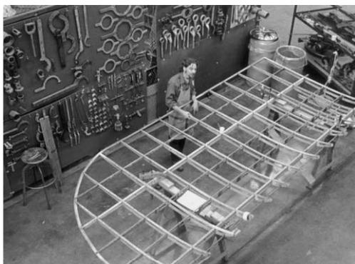
Figura 14. Estrutura de asa *spar-and-rib* típica da primeira geração de aviões de madeira.
